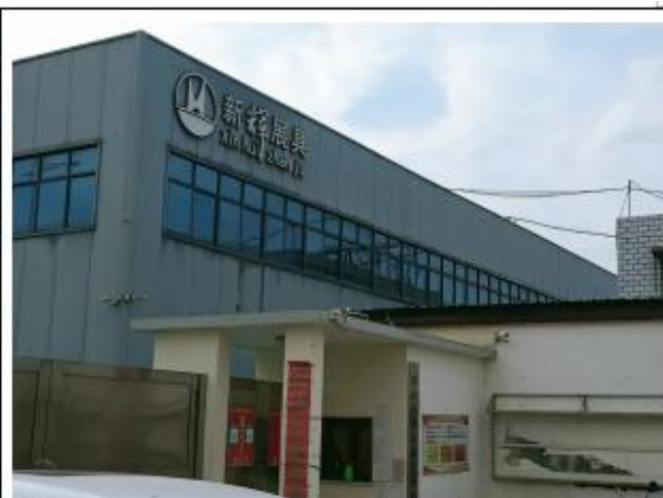
项目厂区大门
