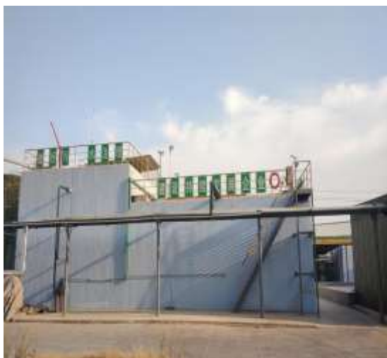
厂区污水处理站
