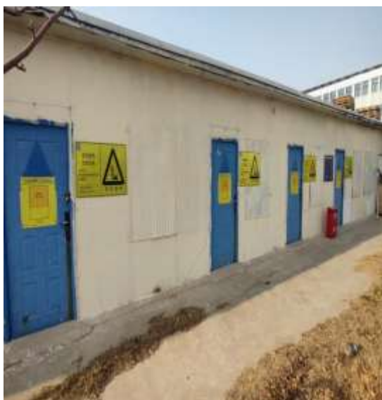
现有危废暂存间
