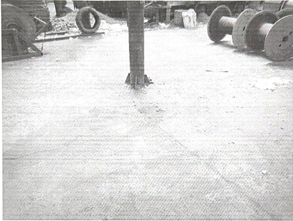
生强线材厂原坠落现场
